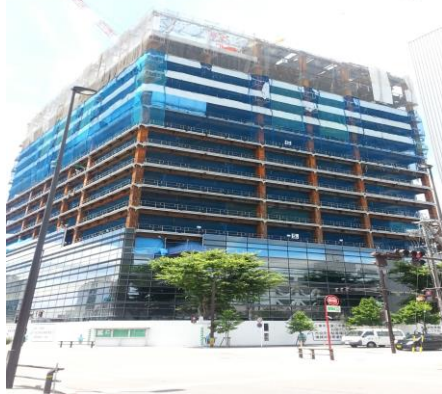
新庁舎現場・最上階までの全貌(15F)
