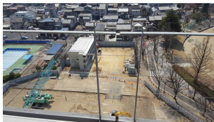
一宮市民病院南側、新病棟建設予定地
