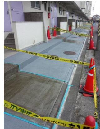
市営住宅の滑り止め
