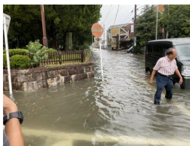
浸水被害地区の道路冠水
