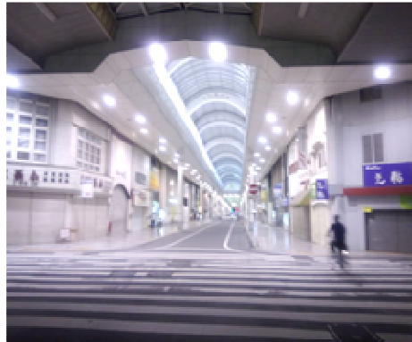
本町商店街2~4丁目アーケード
