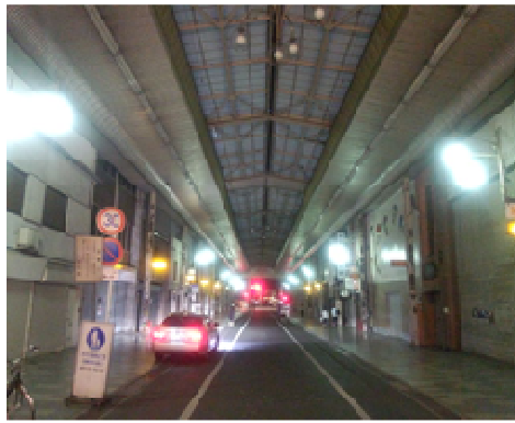
本町商店街1丁目アーケード
