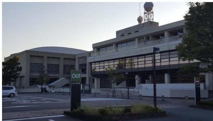
愛知県から移譲を受ける、尾西グリーンプラザ
