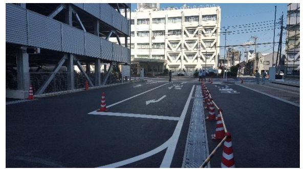
本庁舎西側・自走式立体駐車場完成
