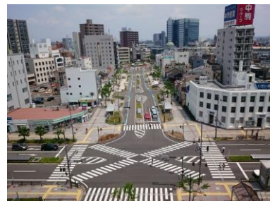
駅前からの無電柱化の状況
