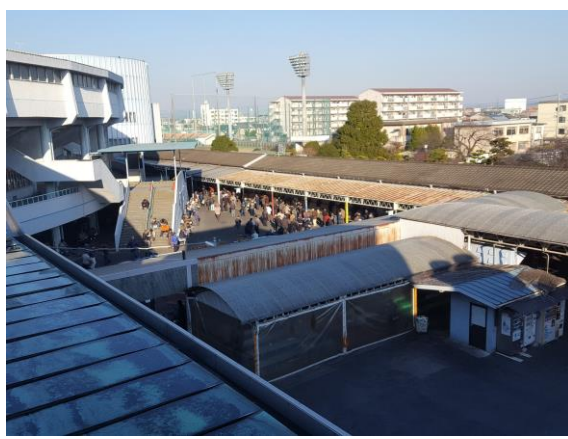
場外車券売場建設予定地 (約2,800平方メートル)
