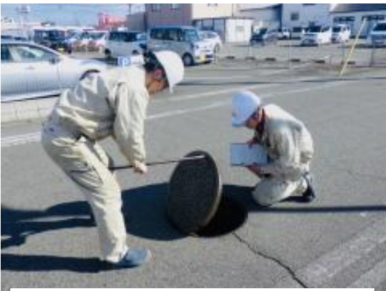
道路下、下水道管空洞調査
