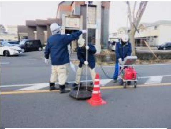
下水道管の調査点検中の作業写真
